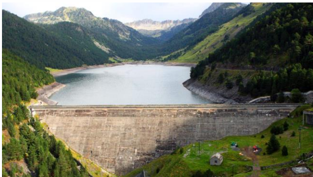
Barrage de l'Oule
