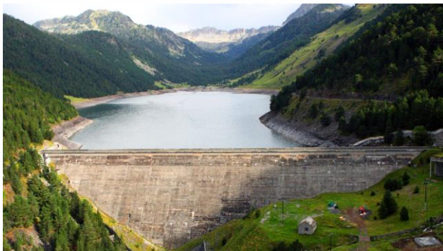
Barrage de l'Oule
